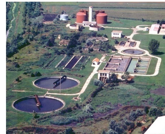
Postrojenje za prečišćavanje komunalnih otpadnih voda
